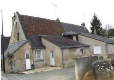
Ferme ancienne de la rue des Locquets
